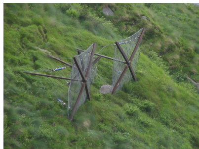
fig 2 - Vista generale di un blocco roccioso arrestato da una struttura fermaneve monancoraggio
